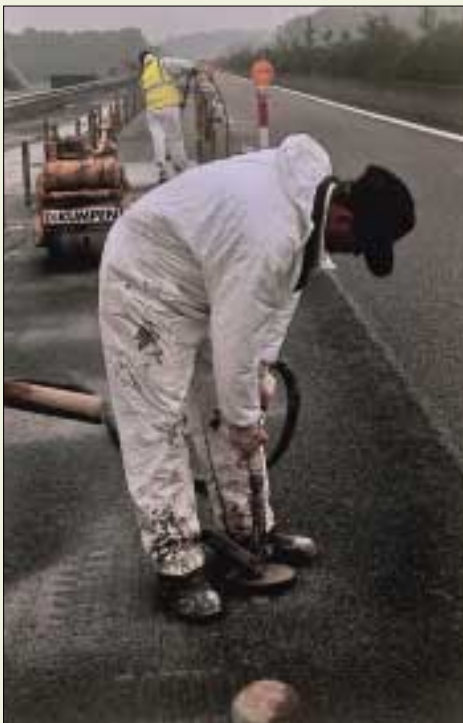
Injectie in boorgaten E411
